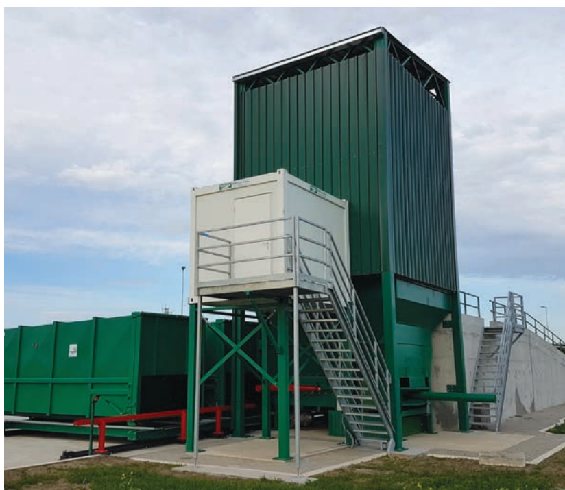
Pretovarna stanica Bačka Topola, kapacitet 269 m 3 /h
