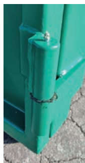
Panti s podmazivanjem
