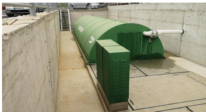
Biorotori u funkciji pročišćavanja otpadnih voda iz naselja do 2000 ES Biorotors work for waste water treatment from towns up to 2000 persons
