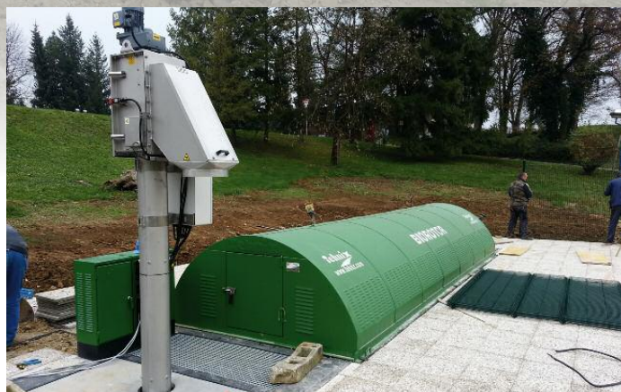
U sklopu kompleksa hotela u Sloveniji - sa automatskim izvlačačem krutina Within the hotel complex in Slovenia - with automatic extraction of solids
