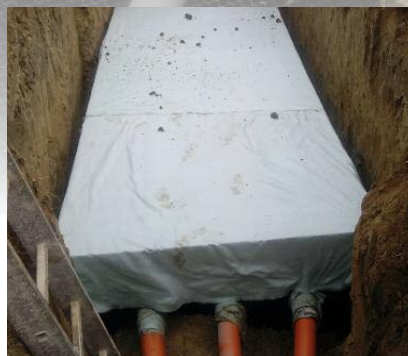
Ugradnja upojnih bioboxeva / Installation of absorption biobox
