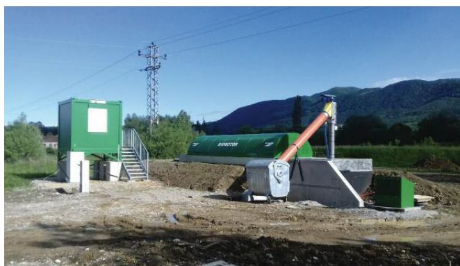
Biorotori u funkciji pročišćavanja otpadnih voda iz naselja do 2000 ES Biorotors work for waste water treatment from towns up to 2000 persons
