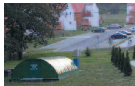
Biorotor Tehnix ugrađen uz apartmansko naselje
