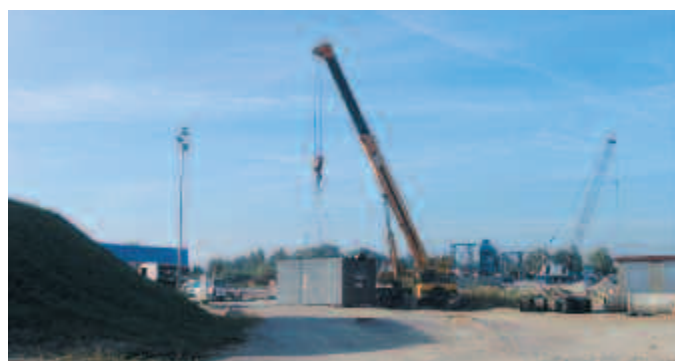
Istovar i ugradnja separatora Tehnix
