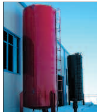
Vertikalni spremnici prema DIN 6618
