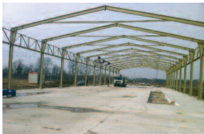
Moderna konstrukcijska rješenja
