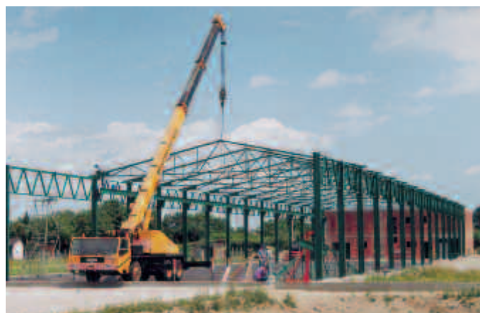
Montaža metalne konstrukcije
