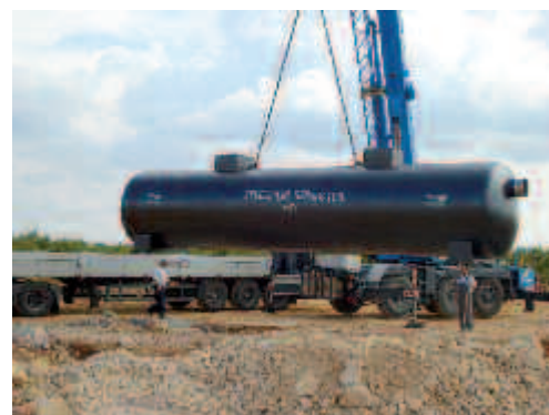
Montaža specijalnog separatora tip TEHNIX
