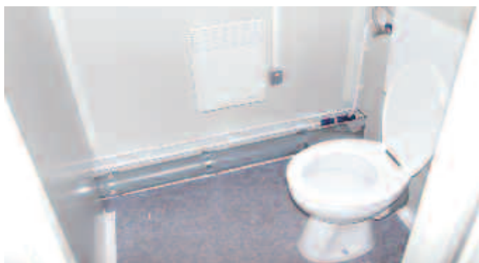
Izvedba vodovodnih instalacija sa Wavin sistemom cijevi
