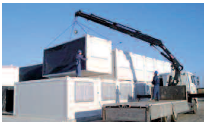
Montaža kontejnerskog naselja na lokaciji
