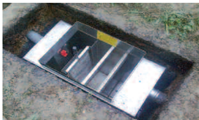
Prikaz ugradnje mastolova
