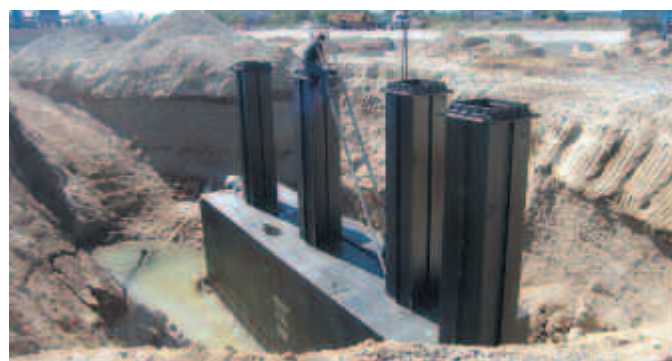
Primjer ugradnje separatora
