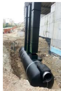
Prikaz ugradnje specijalnih separatora na terenu / Installation of a special separator on site
