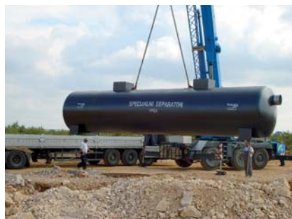
Prikaz ugradnje specijalnih separatora na terenu / Installation of a special separator on site
