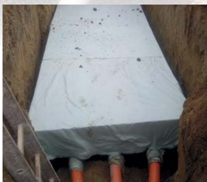
Ugradnja upojnih bioboxeva / Installation of absorption biobox
