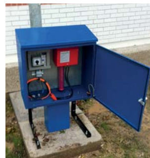
UPRAVLJAČKI ELEKTROPANEL SPECIJALNOG SEPARATORA CONTROL ELECTROPANEL OF SPECIAL SEPARATOR
