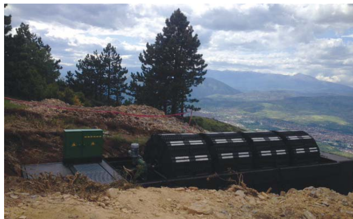
Montaža i ugradnja biorotora u ekstremno teškim i zahtjevnim prostornim uvjetima za naselja i gospodarsko stambene objekte Assembly and installation of biorotor in extremely difficult and challenging conditions for settlements and household facilities
