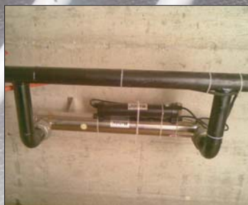
UV dezinfekcija / UV disinfection
