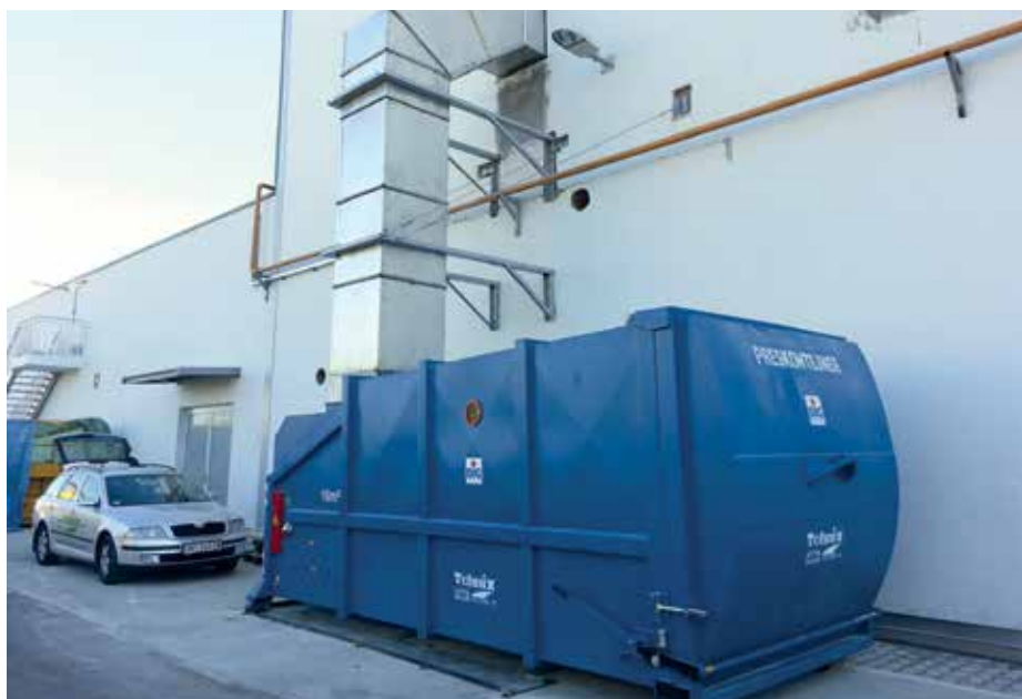
PKH U EKSPLOATACIJI HPC IN OPERATION
